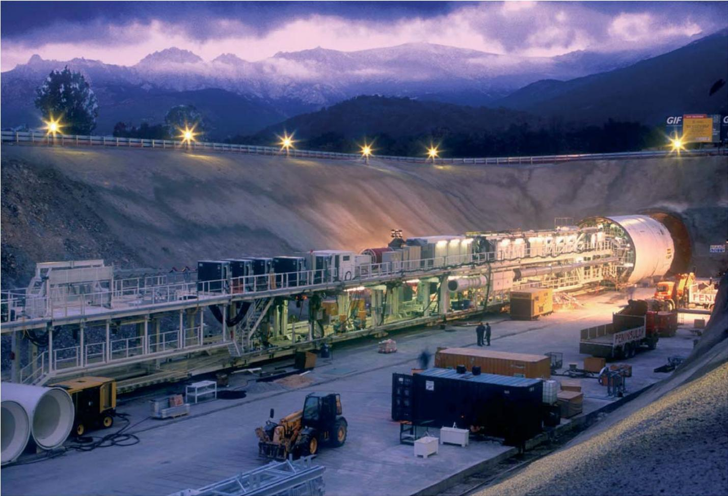
Fig. 3. Doble escudo Túneles Guadarrama.
